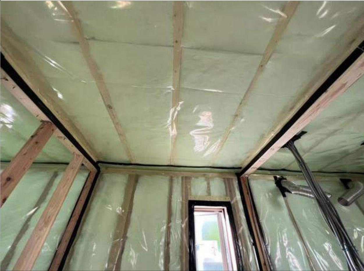
2-1口床・壁・天井（屋根）に図面通りの断熱材を使用する。(2/2)
