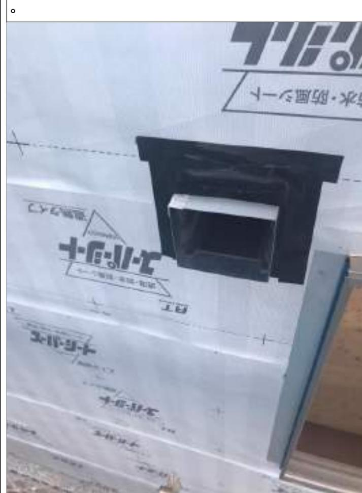
3-11 配管、配線が2本以上貫通する場合は、さや管を使用し、防水措置を適切に処理する。
