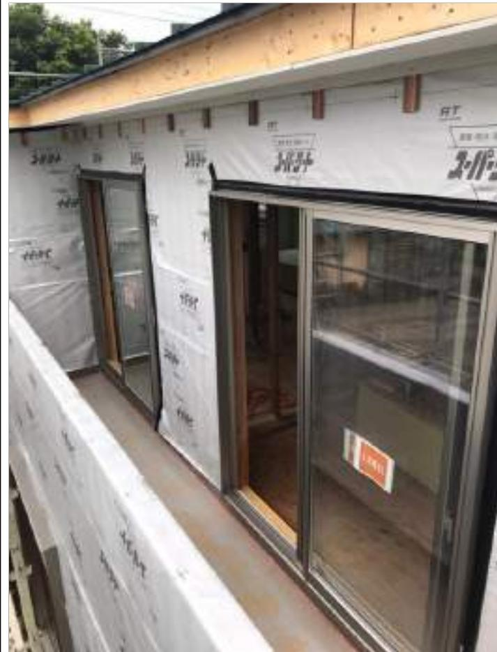
3-5口透湿防水シート（防水紙）の重ね代は、左右150mm、上下90mm以上取る。ステープルのピッチは100mmを目安とする。出入隅部は重ねつくりの施工をし、その際重ね代を150mm以上確保し、かつ重ね部分を乱にする。
