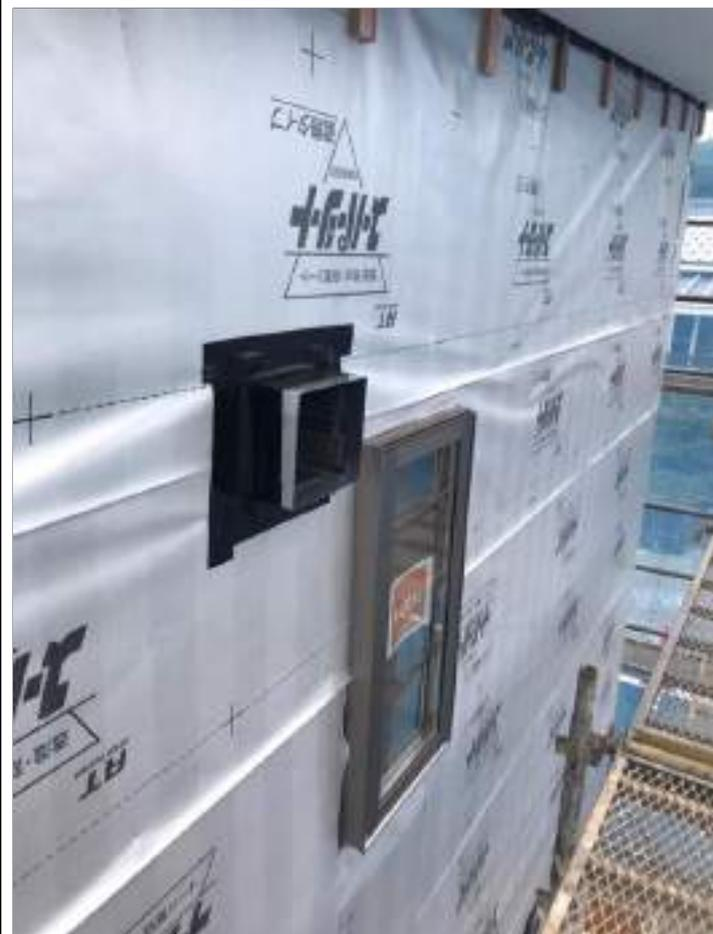
3-7 土台水切りと土台を両面粘着防水テープで張る。雨押さえに両面粘着防水テープを張る。
