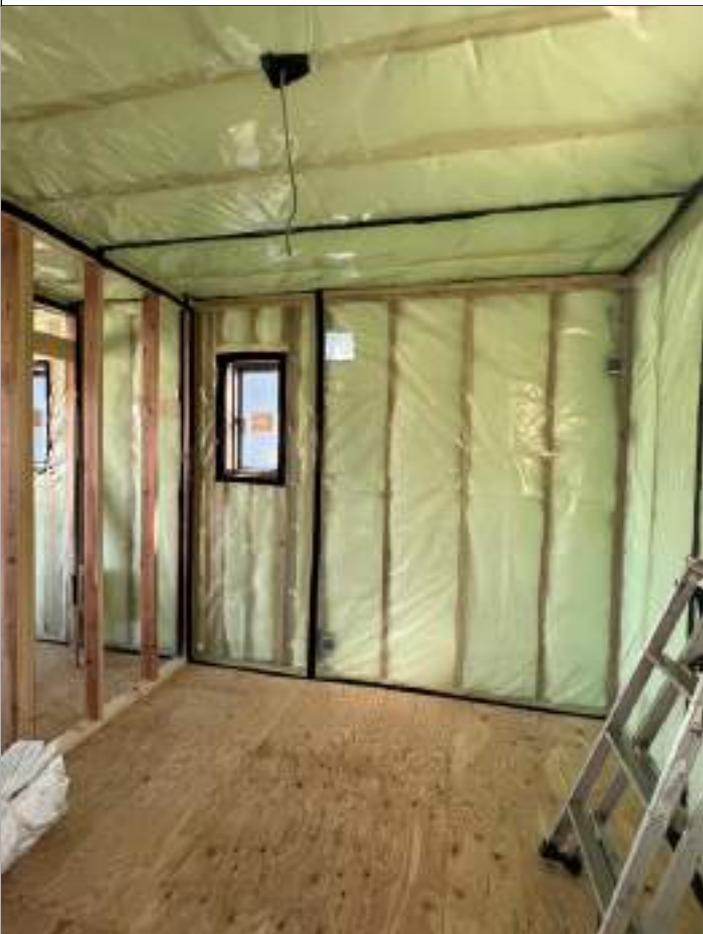
2-3口断熱材は隙間・欠損・施工不良がないように施工する。断熱材は配管部分に隙間ができないように気を付ける。
